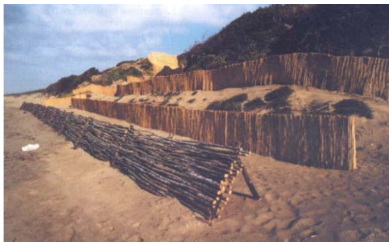
Fig.8- Particolare della barriera basale in viminata
