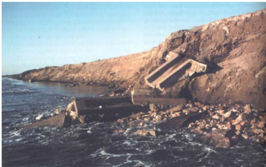
Fig.7 – Crollo causato dalla erosione della duna
